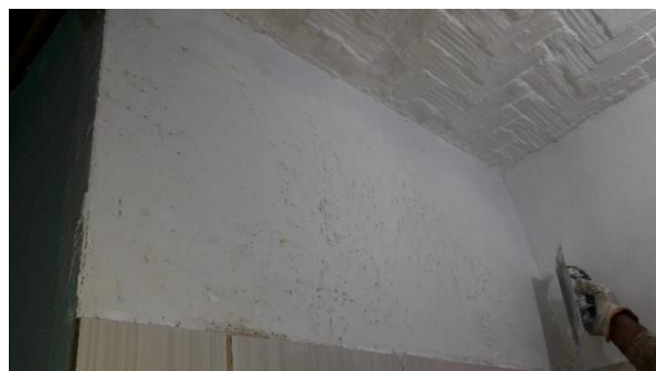
Emassamento em propriedade rural em Mariana – fevereiro/2018 (Crédito: Divulgação Fundação Renova)
