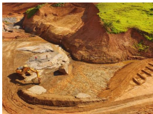
Dique intermediário F. Floresta – fevereiro/2018 (Crédito: Divulgação Fundação Renova)
