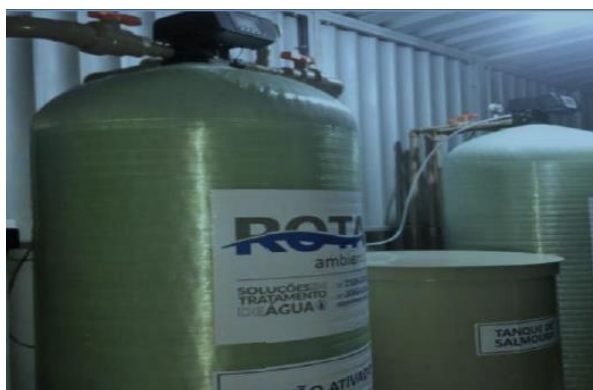
Start up – Sistema Abrandador de Poços - São Tomé do Rio Doce – fevereiro/2018 (Crédito: Divulgação Fundação Renova)
