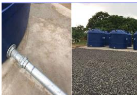
Adequação ETA - Vila Isa para período chuvoso - Interligações dos reservatórios - fevereiro/2018 (Crédito: Divulgação Fundação Renova)
