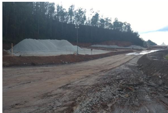
Pátio de estocagem – fevereiro/2018 (Crédito: Divulgação Fundação Renova)
