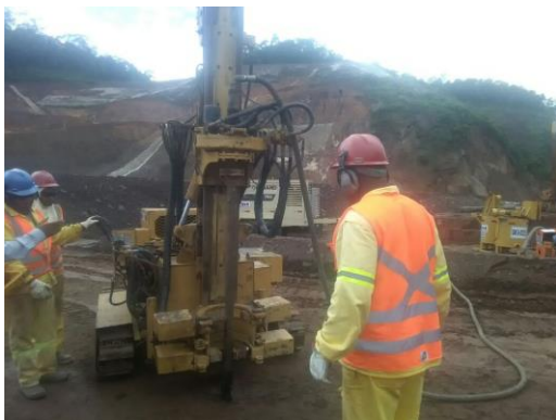
Injeção de cimento – fevereiro/2018 (Crédito: Divulgação Fundação Renova)
