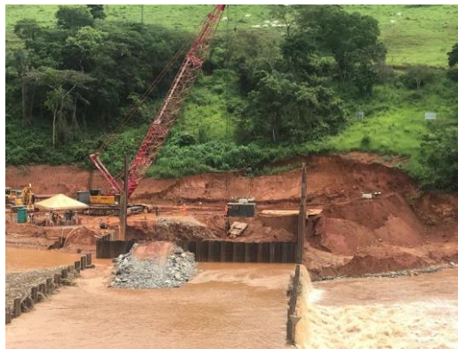
Barramento C Ombreira esquerda – fevereiro/2018 (Crédito: Divulgação Fundação Renova)
