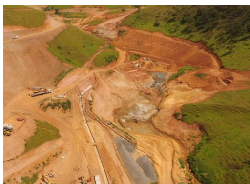
Dique intermediário/principal e vertedouro F. Floresta- fevereiro/2018 (Crédito: Divulgação Fundação Renova)
