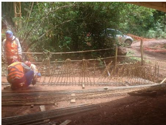
Execução de armadura de viga na reforma da ponte Mariana x Bento, em Mariana – dezembro/2017 (Crédito: Divulgação Fundação Renova)
