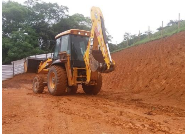
Acerto de terreno e escavação mecanizadas das Sapatas S13 à S28 na reconstrução de residência em propriedade rural do Sr. Josimar, em Mariana – dezembro/2017 (Crédito: Divulgação Fundação Renova)
