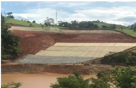
Descomissionamento do Setor 8 - dezembro/2017 (Crédito: Divulgação Fundação Renova)
