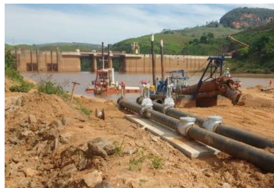
Execução linha Pead – dezembro/2017 (Crédito: Divulgação Fundação Renova)
