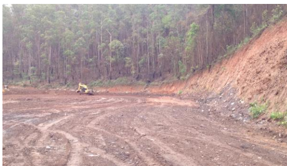
Eixo 1 - Conclusão do pátio de acesso ao pinheirinho, para início da estocagem de materiais de construção da barragem - dezembro/2017 (Crédito: Divulgação Fundação Renova)
