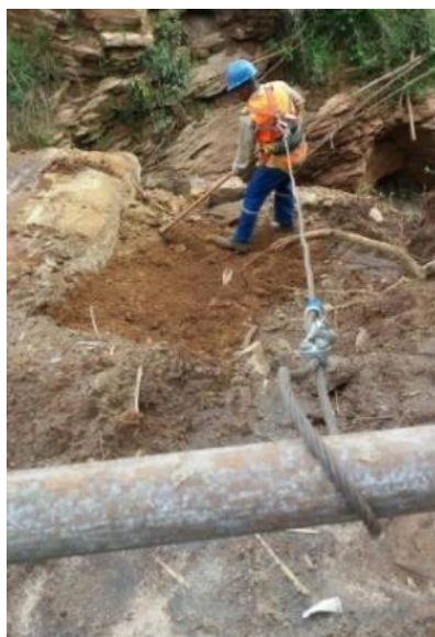
Escavação/demolição de rocha na reforma da ponte de Bento x Camargos, em Mariana – dezembro/2017 (Crédito: Divulgação Fundação Renova)
