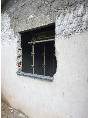
Instalação de peitoril na Reforma na propriedade rural do Sr. Pedro Martins, em Mariana – dezembro/2017 (Crédito: Divulgação Fundação Renova)
