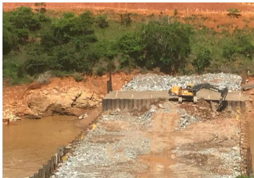
Conclusão da ombreira direita do Barramento C – dezembro/2017 (Crédito: Divulgação Fundação Renova)
