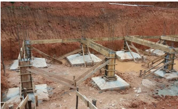
Forma, armação e concretagem dos pilares nas Sapatas S1 à S9 reconstrução de residência em propriedade rural do Sr. Maria da Conceição, em Mariana – dezembro/2017 (Crédito: Divulgação Fundação Renova)
