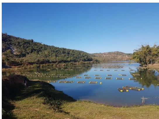
Visita Técnica na Barragem de Magalhães, em Padre Viegas, Mariana (MG) - agosto/2017 (Crédito: Divulgação Fundação Renova)
