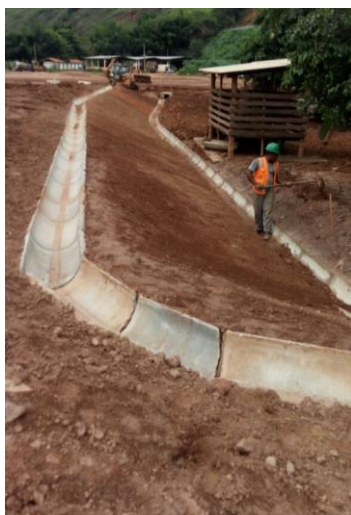
Meia cana DN 500mm na rede de drenagem no campo Barralanguense, em Barra Longa – dezembro/2017 (Crédito: Divulgação Fundação Renova)
