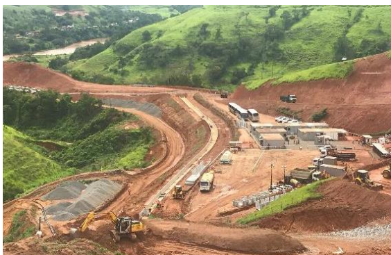
Drenagem superficial diques FF – dezembro/2017 (Crédito: Divulgação Fundação Renova)
