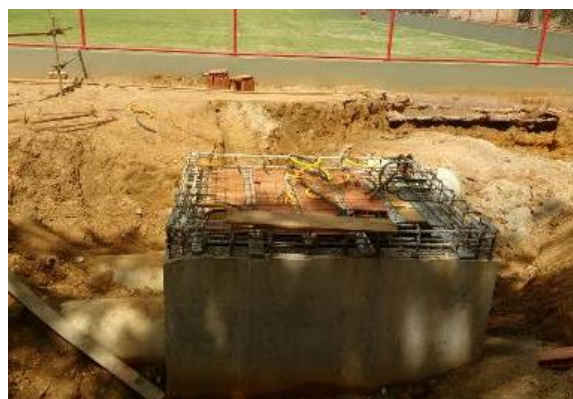
Montagem de forma em laje pré-moldadas para tampa CX02 no campo Barralonguense, em Barra Longa – dezembro/2017 (Crédito: Divulgação Fundação Renova)
