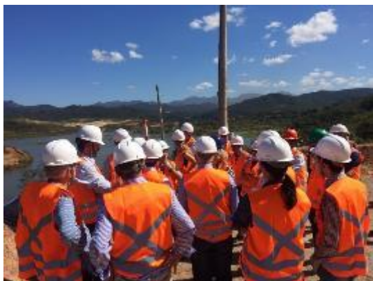
Visita ao dique S4 para conhecer a obra de alteamento, concluída em janeiro deste ano (Crédito: Divulgação Fundação Renova)
