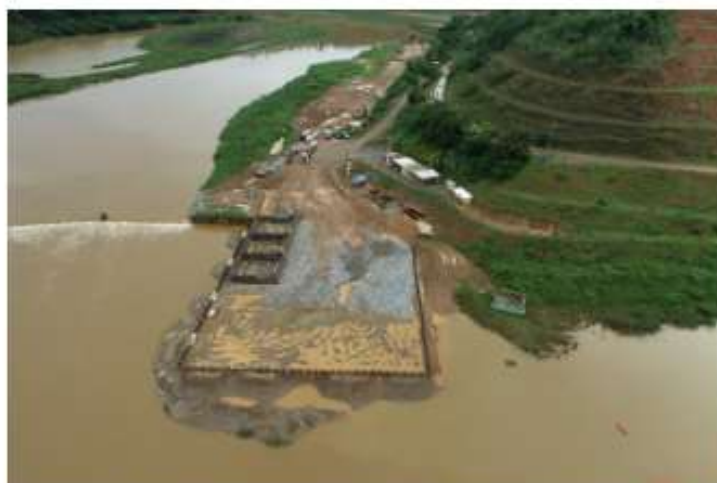
Figura 9 - Vista aérea Ponto de Apoio
