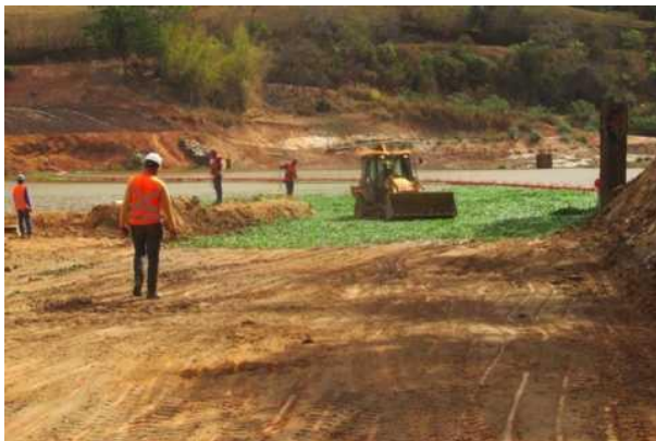
Monitoramento das obras realizadas na área impactada – setembro/2017 (Crédito: Divulgação Fundação Renova)
