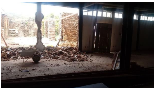
Início das obras de reforma do Centro de Informação e Atendimento de Mariana (MG) – setembro/2017 (Crédito:
