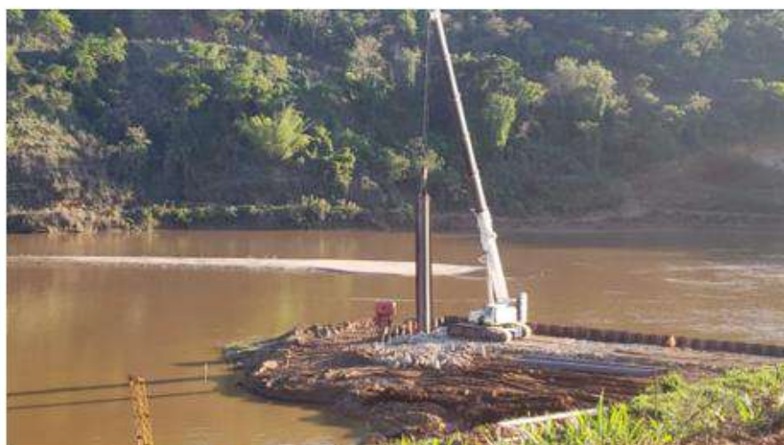
Figura 7 - Execução de cravação de estacas
