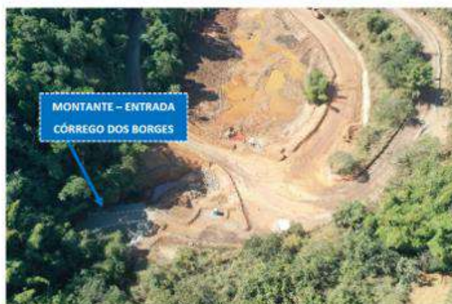
Figura 24 - Montante Córrego dos Borges
