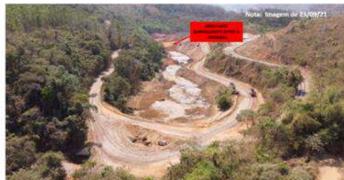
Figura 21 - Montante Barramento Setor 4 - Entrada
