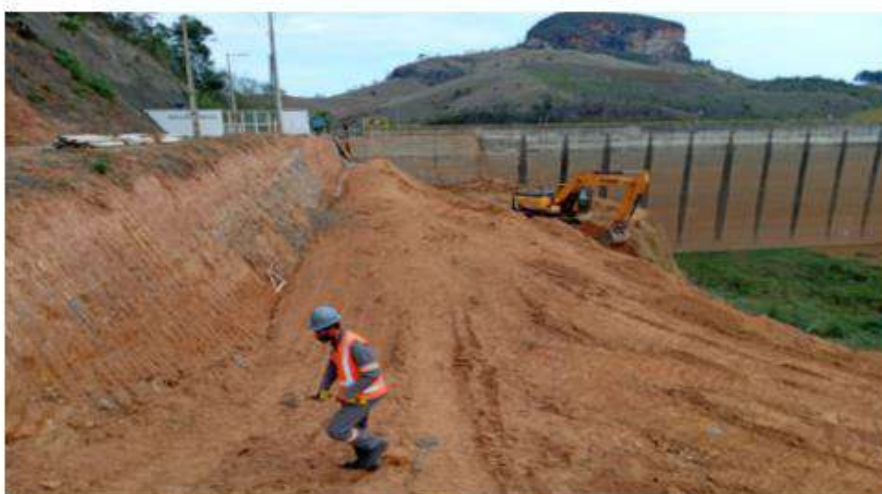
Figura 9 - Remoção de terramesh
