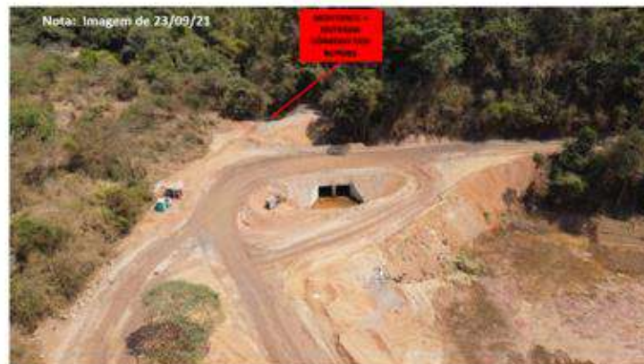
Figura 20 - Montante Córrego dos Borges
