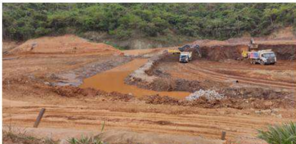
Figura 2 - Vista do Dique Setor 4
