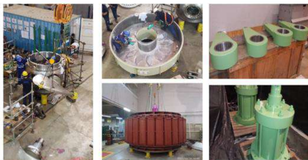
Figura 15 - Montagem da UG1
