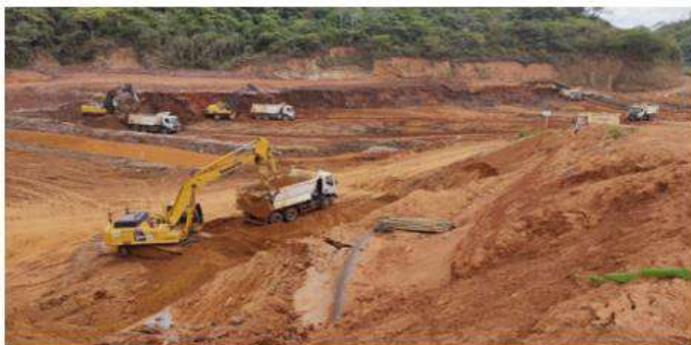
Figura 1 - Vista à jusante do Dique Setor 4
