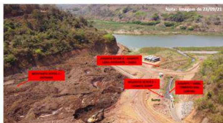
Figura 22 - Jusante do Dique Setor 4
