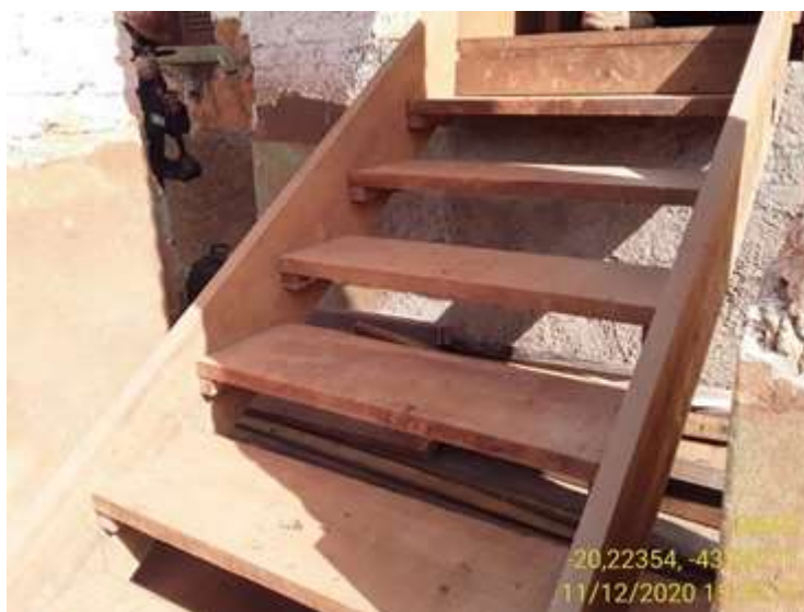
Foto relacionada à: Consorcio Reassentamento Paracatu – Tapume e limpeza Igreja de Gesteira - Infra - Execução da escada de acesso - Dezembro/2020
