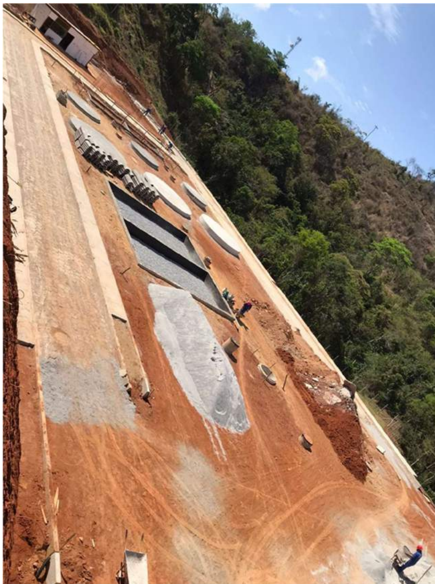
Foto relacionada à: Córrego Novo - Estação de tratamento - set/20
