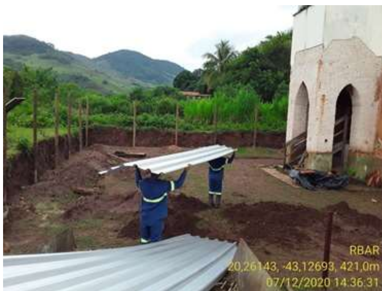
Foto relacionada à: Consorcio Reassentamento Paracatu – Tapume e limpeza Igreja de Gesteira - Infra - Transporte de material - Dezembro/2020
