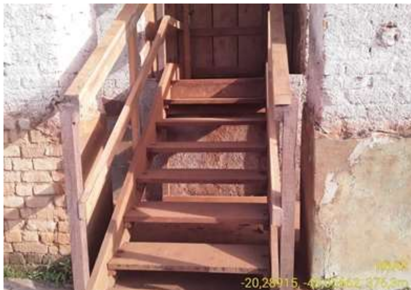
Foto relacionada à: Consorcio Reassentamento Paracatu – Contrato ADM: Barra Longa – Infra - Execução da escada de acesso - Igreja de Gesteira - Dezembro/2020
