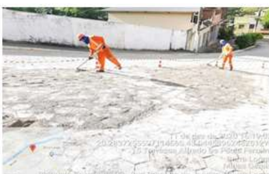
Foto relacionada à: BTEC – Manutenção de Acessos – Reparo Calçamento em Vias Urbanas - Município Barra Longa - Rua Matias Barbosa - Dezembro/2020
