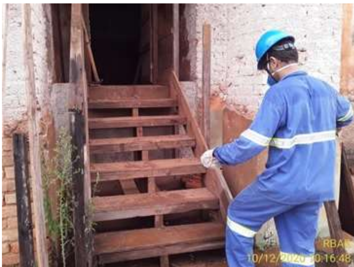
Foto relacionada à: Consorcio Reassentamento Paracatu – Tapume e limpeza Igreja de Gesteira - Infra - Execução da escada de acesso - Dezembro/2020
