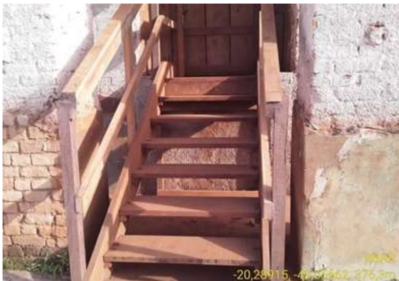
Foto relacionada à: Consorcio Reassentamento Paracatu – Tapume e limpeza Igreja de Gesteira - Infra - Execução da escada de acesso - Dezembro/2020
