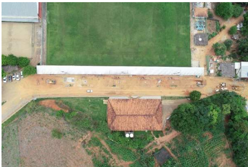
Foto relacionada à: Drenagem Rio Doce Terrayama – novembro/2020.
