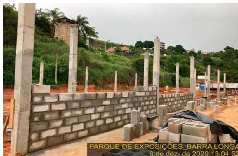
Foto relacionada à: Consorcio Reassentamento Paracatu – Obras do Parque – Início De Alvenaria Nos Galpões - - Dezembro/2020
