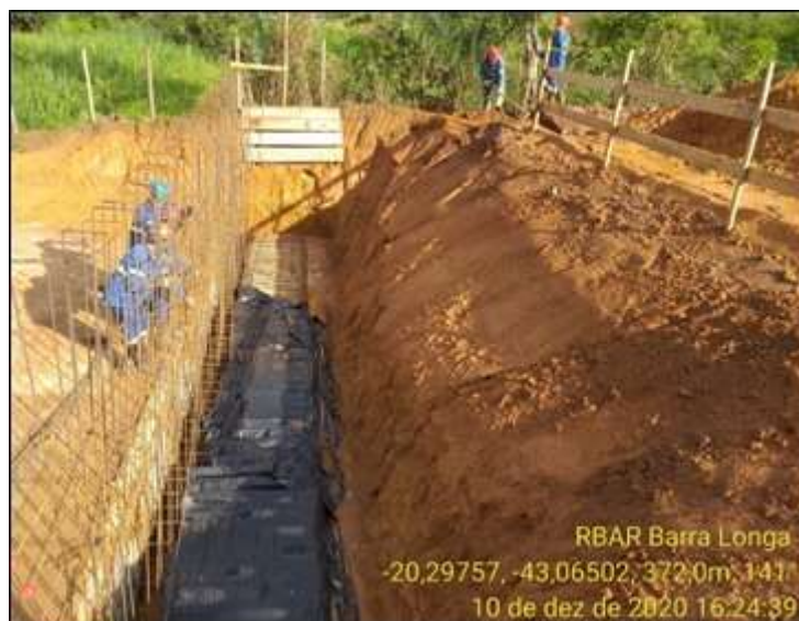
Foto relacionada à: Consorcio Reassentamento Paracatu – Adequação Transbordo - Infra - Armação do muro - Dezembro/2020
