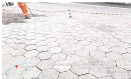
Foto relacionada à: BTEC – Manutenção de Acessos – Reparo Calçamento em Vias Urbanas - Município Barra Longa - Rua Matias Barbosa - Dezembro/2020
