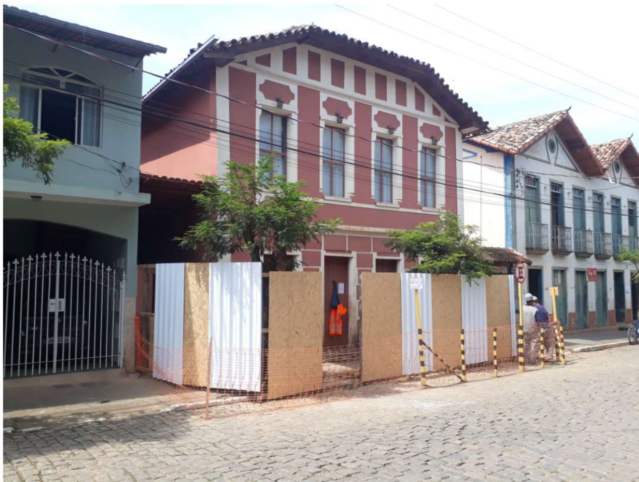
Foto relacionada à: Início excução de obra de restauro em imóvel tombado no município de Barra Longa- Agosto/2020.
