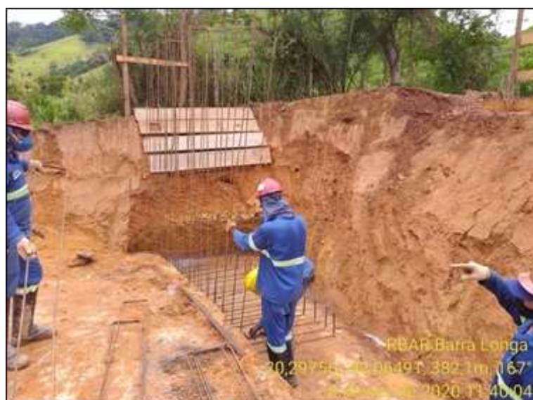
Foto relacionada à: Consorcio Reassentamento Paracatu – Adequação Transbordo - Infra - Armação do muro - Dezembro/2020
