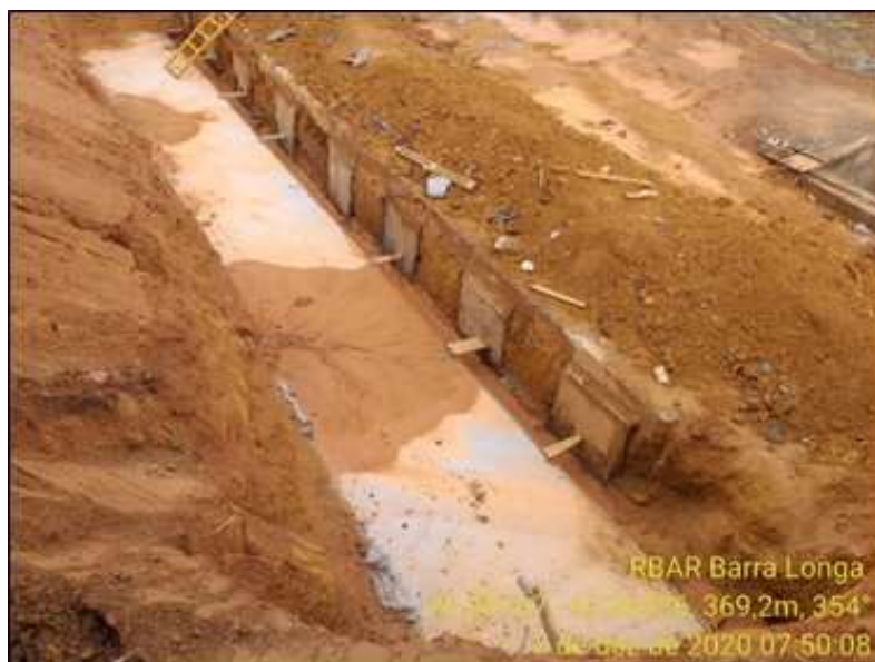
Foto relacionada à: Consorcio Reassentamento Paracatu – Adequação Transbordo - Infra - Concreto magro base do muro - Dezembro/2020
