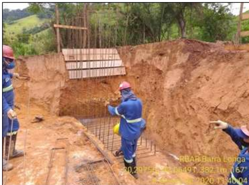
Foto relacionada à: Consorcio Reassentamento Paracatu – Contrato ADM: Barra Longa– Infra - Armação do muro – Adequação Transbordo - Dezembro/2020
