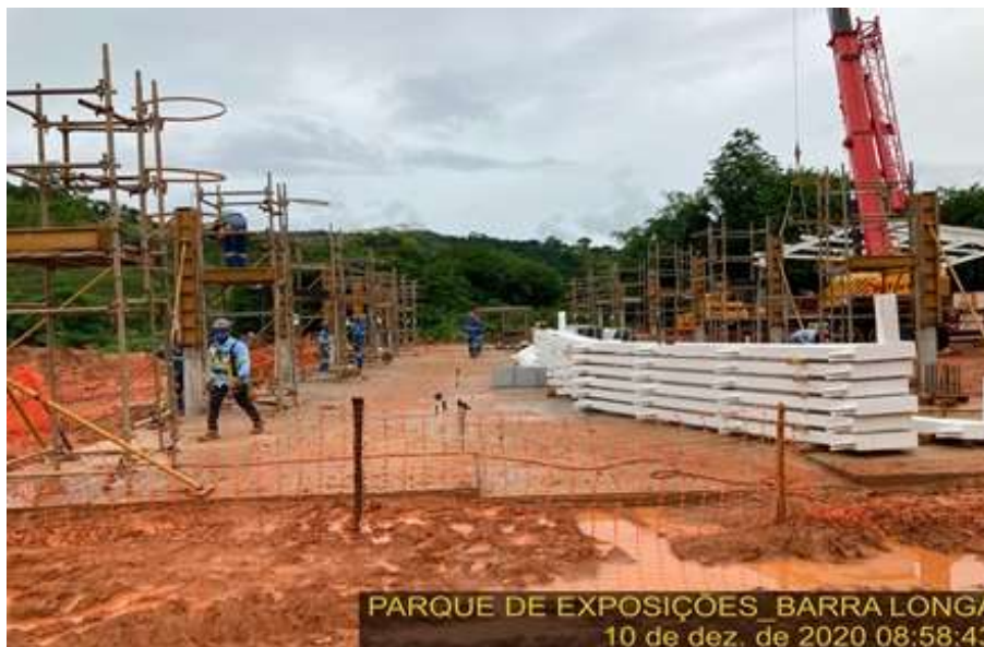
Foto relacionada à: Consorcio Reassentamento Paracatu – Obras do Parque Concreto Pilares Do Estábulo - Dezembro/2020
