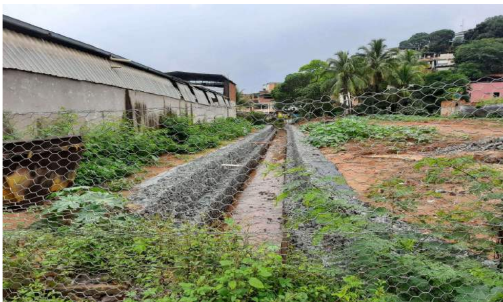
Foto relacionada à: Ipatinga - Obras de rede de saneamento - dez/20
