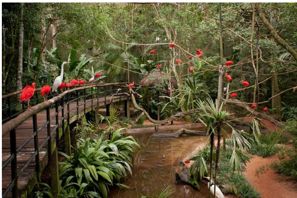
Imagem 4 - Exemplos de ponte em madeira.
