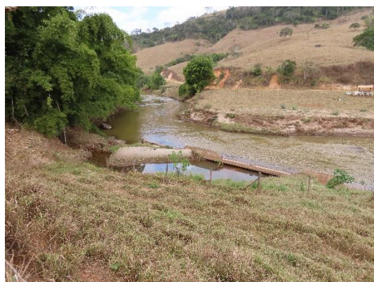
02. Trechos da área vistoriada.
